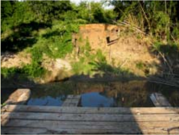
Hier geht's nicht weiter...
